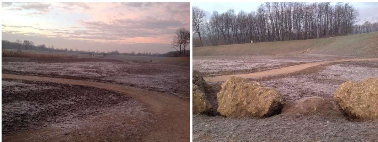
Figura 43 - esempio di sedimentazione all'interno vasca torrente Lura a Lomazzo post evento invasivo e lavorazione in attesa della semina
