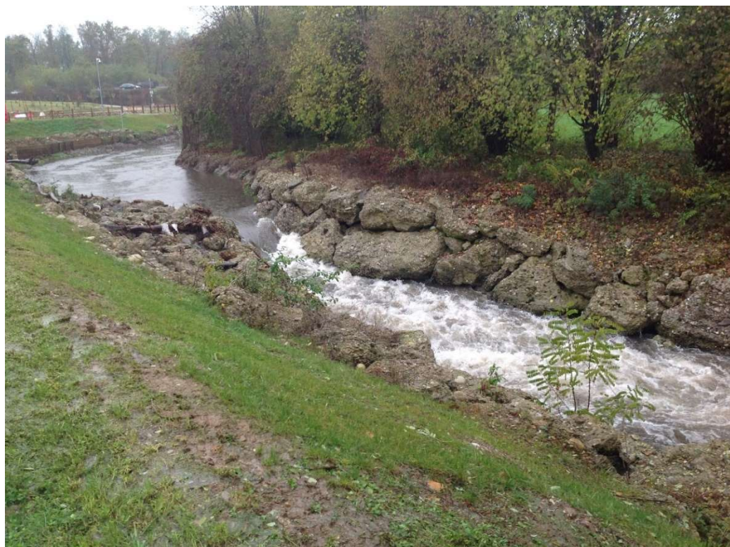
Figura 23 –restringimento in massi sul torrente Lura a Lomazzo
