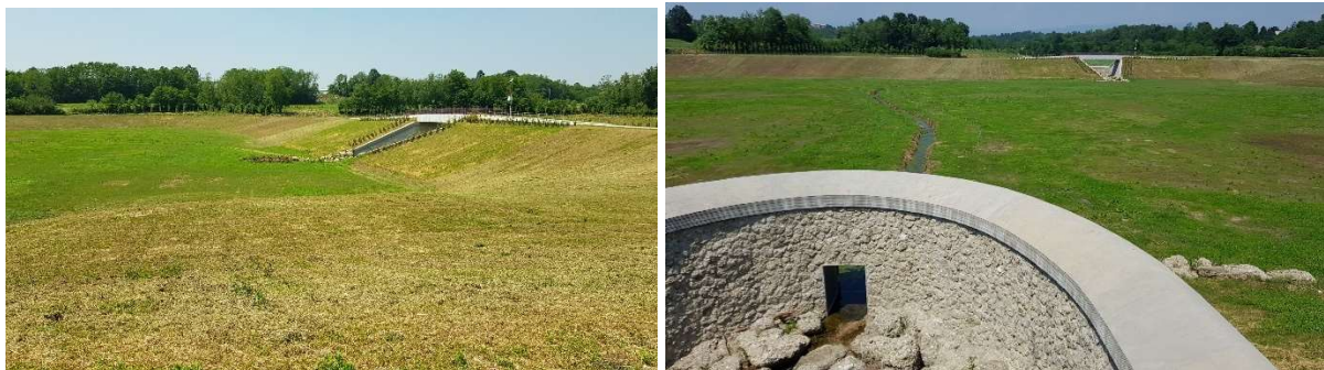
Figura 25 – Manufatto di restituzione (vista da valle e vista soglia di sfioro con luce di scarico)
